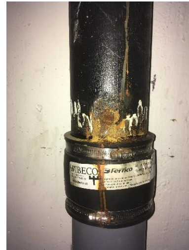
Rostgenomslag på avloppsledning.
