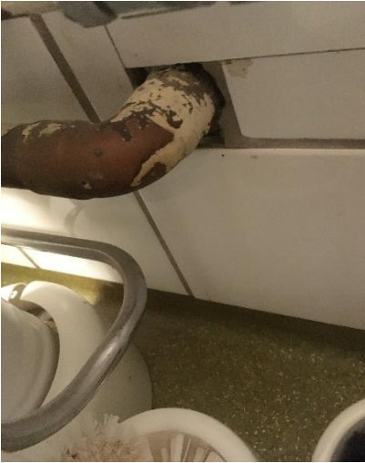
Genomföring utan täckbricka – Risk för fuktrinträning
