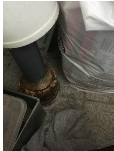
Avloppsanslutning tvättställ, rostigt gjutjärn.
